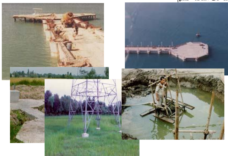
شکل ۱۵- مراحل ساخت و استقرار پایه های دکل برق در شالیزار
