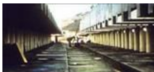
شکل ۶- صفحات بتنی زیر ریلهای راه آهن
